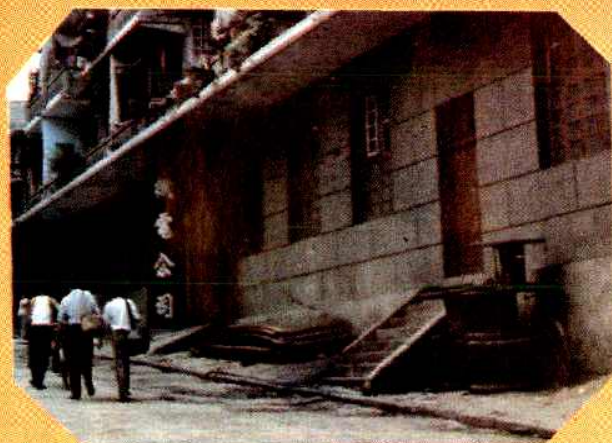
②沅江县机电公司营业楼的一角
