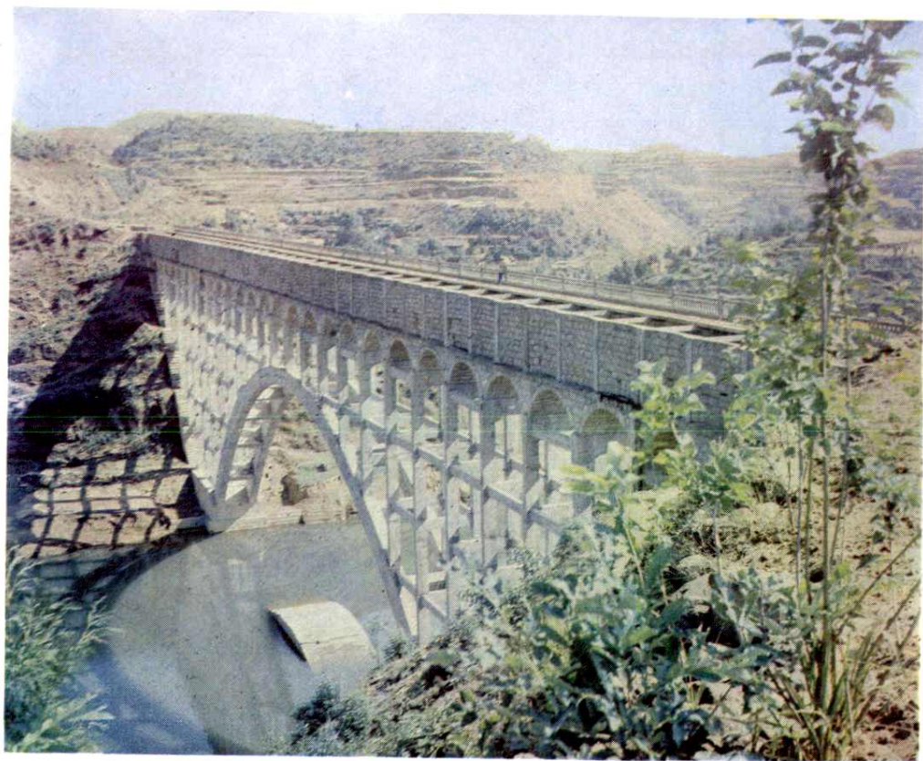
人民渠清水河渡槽
