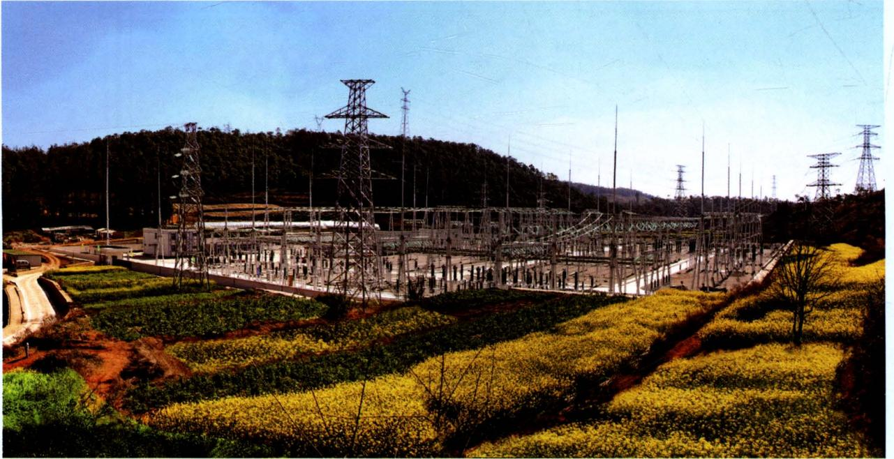
2014年12月主体工程完工，容量为 $2 \times 180$ 兆伏安的220千伏雄关变电站全景（瞿江勇 摄）
