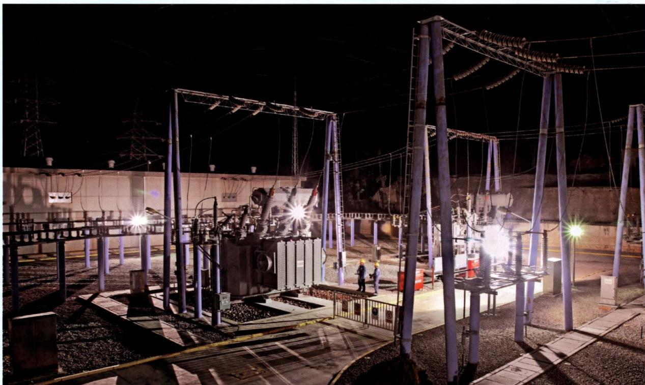
容量为 $2 \times 40$ 兆伏安的110千伏江城变电站主变压器
