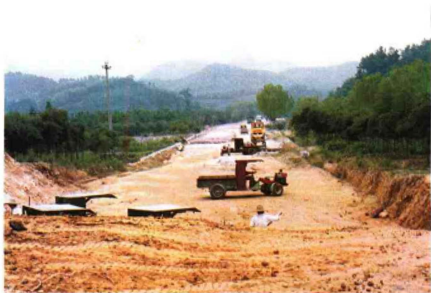
104国道水泥路面工程——上柏段施工
