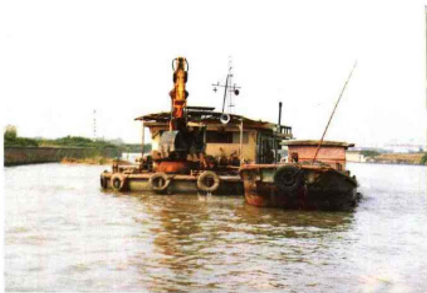
運河中線新市段在疏浚中
