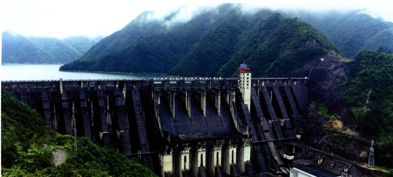
▲湖南镇大型水库(1958年8月水库开工建设,1980年12月竣工。总库容206700万立方米,电站装机容量270000千瓦,是衢州市最大的水库。)
