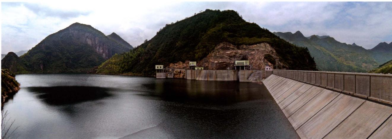
▲江山市白水坑大型水库(2001年2月动工建设,至2003年7月水库建成,电站投产。水库总库容24809万立方米,电站装机容量40000千瓦,成为衢州市首座钢筋混凝土面板堆石坝。)
