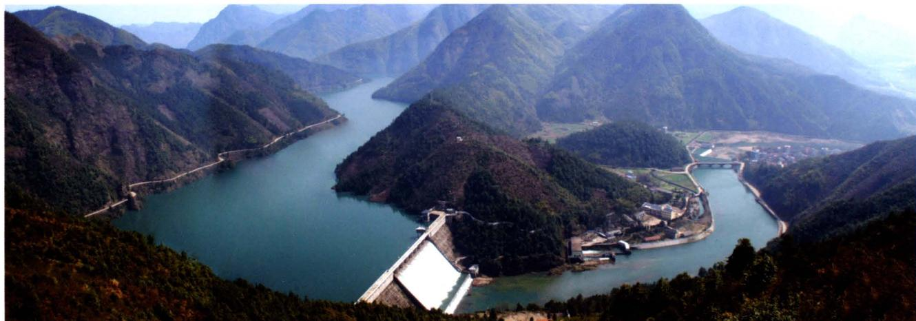
▲江山峡口中型水库(1966年9月动工,1971年7月大坝建成,1973年5月电站投入运行。总库容6340万立方米,电站装机容量14000千瓦,是全市首座县属混凝土重力坝。)
