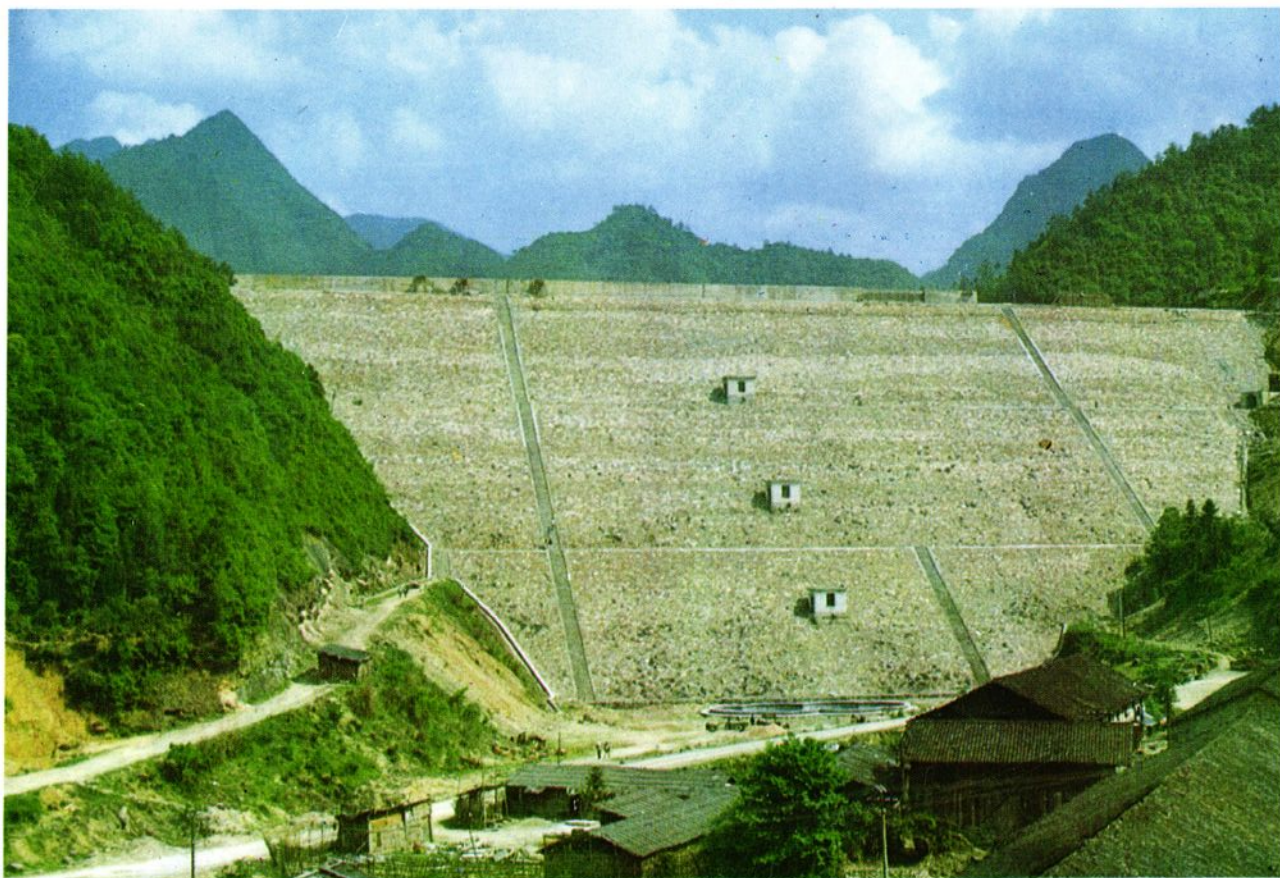
成屏一级水库大坝
