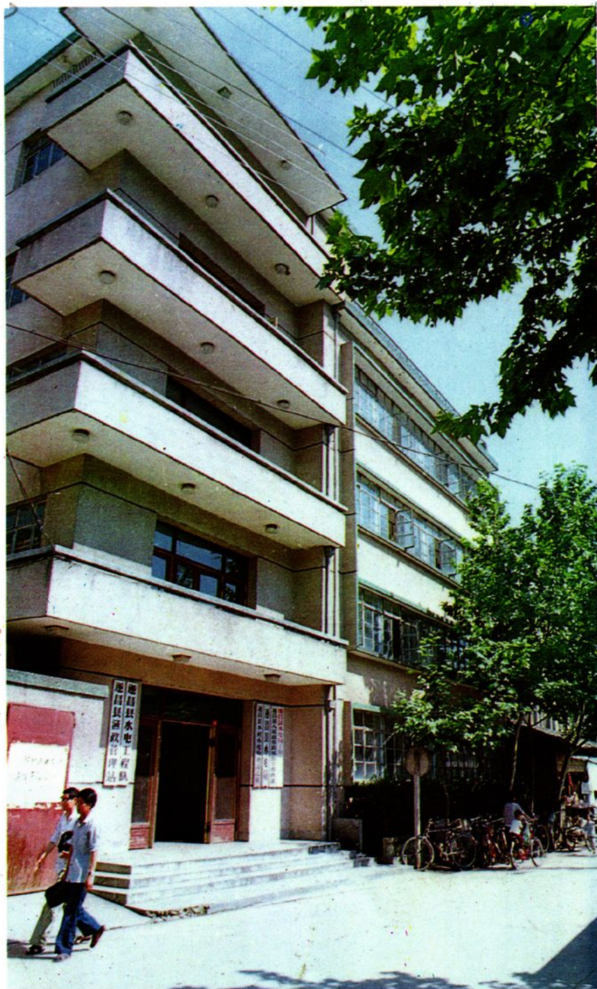
县水电局机关办公楼
