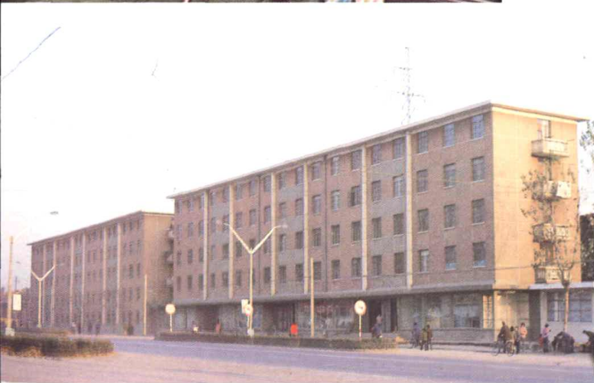
坐落在建设路中段的供电家属楼
