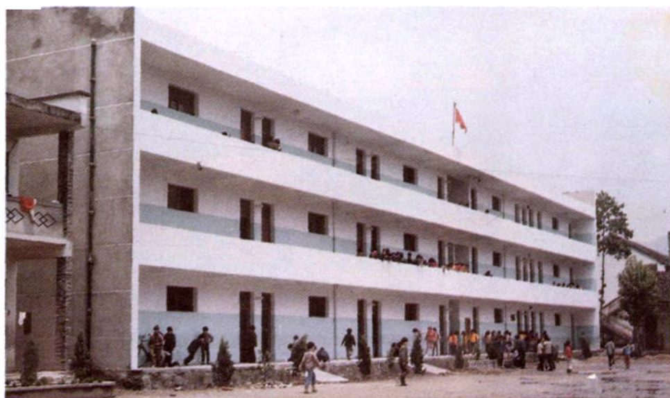
虎鹿镇中心小学教学楼
