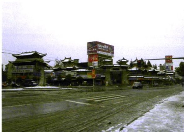
长坂坡仿古建筑群
