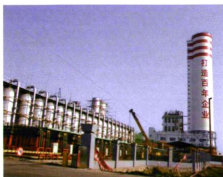
化肥厂尿素造粒塔
