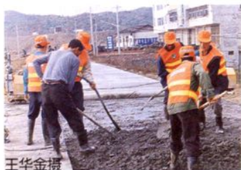
县城河堤路与昌厦公路连接线水泥路面施工
