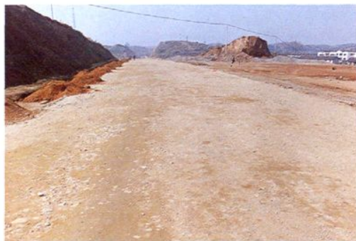
国道 206 线白赤路段公路改善工程
