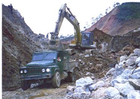
206国道广昌境内『两脑』土方工程施工
