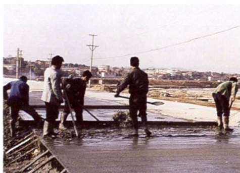
广昌县沿河水泥路面工程施工
