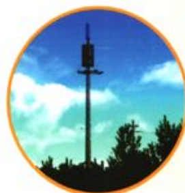
应急通讯基站
