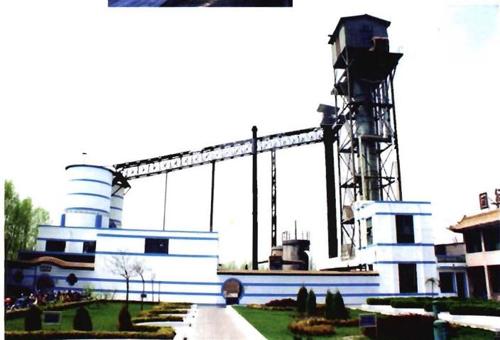
金泰公司硝酸钾造粒塔
