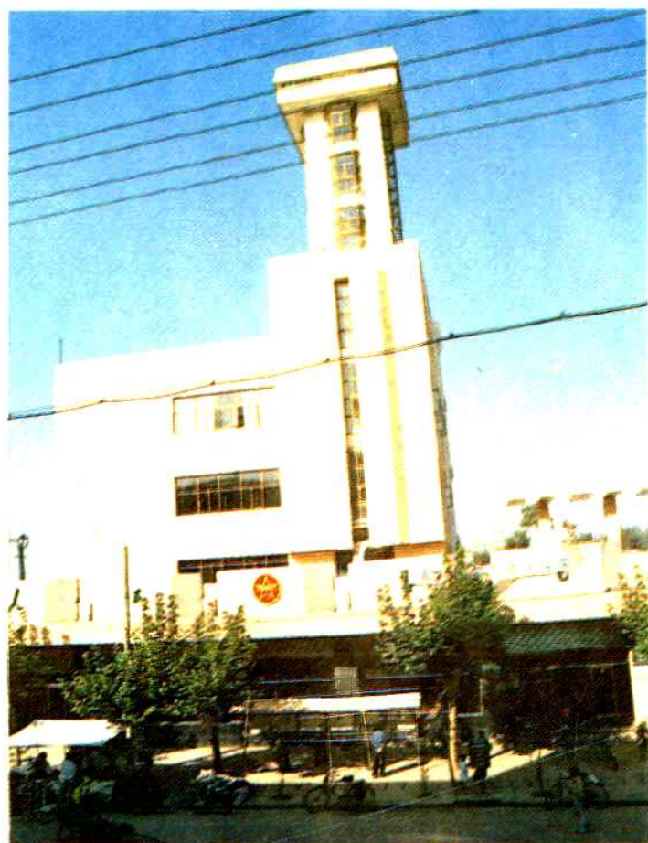
1989年12月25日，竣工投产电信综合大楼，大楼总高36米，建筑面积3160平方米，建筑投资195万元
