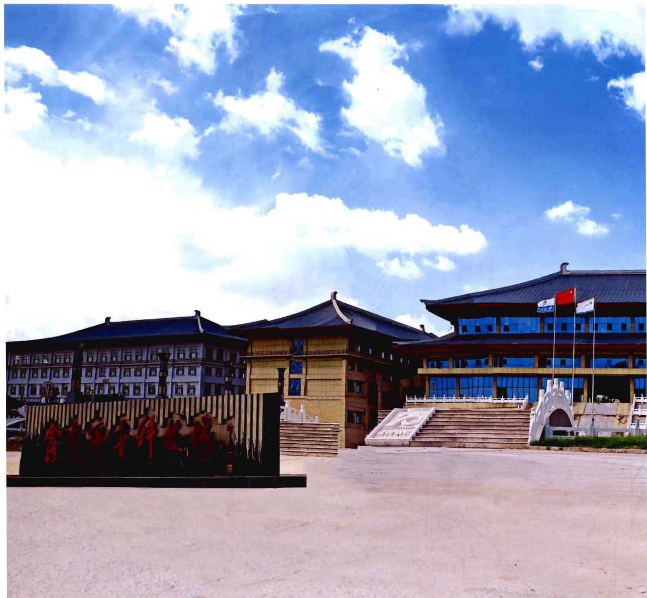
济南市新材料产业园
