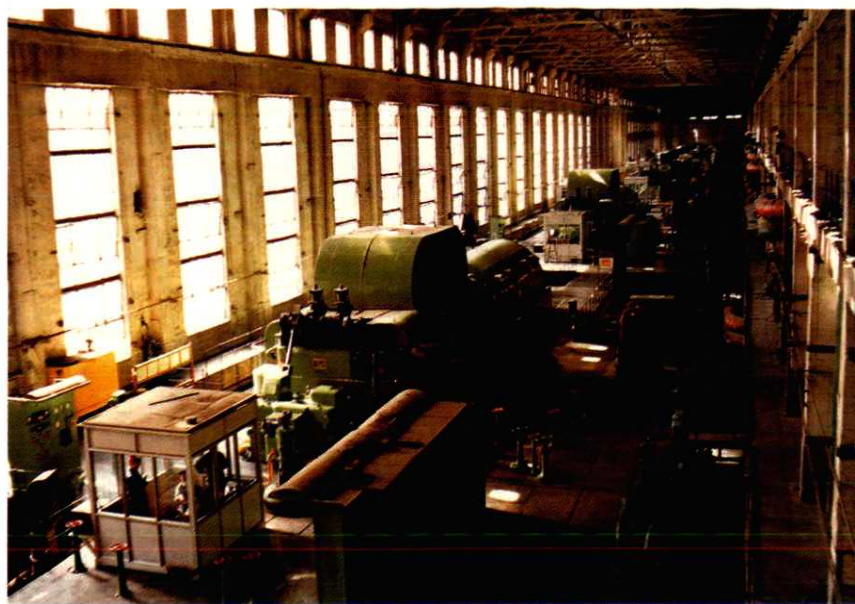
9 阜新电厂内景
