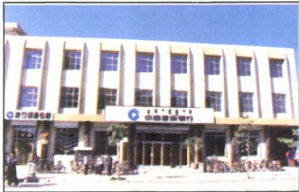
林西县支行办公楼 1989年12月 落成
