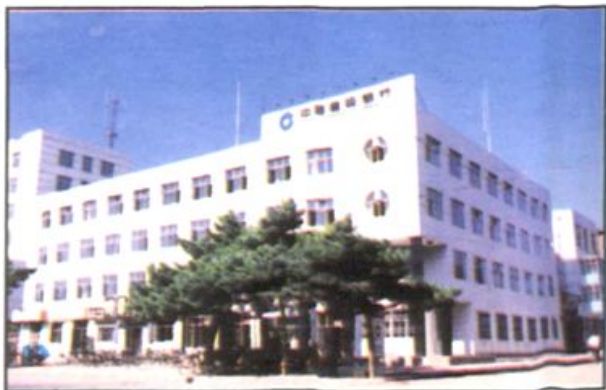
宁城县支行办公楼 1991年10月 落成
