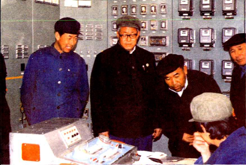
县领导到巴什克其克水电站现场办公
