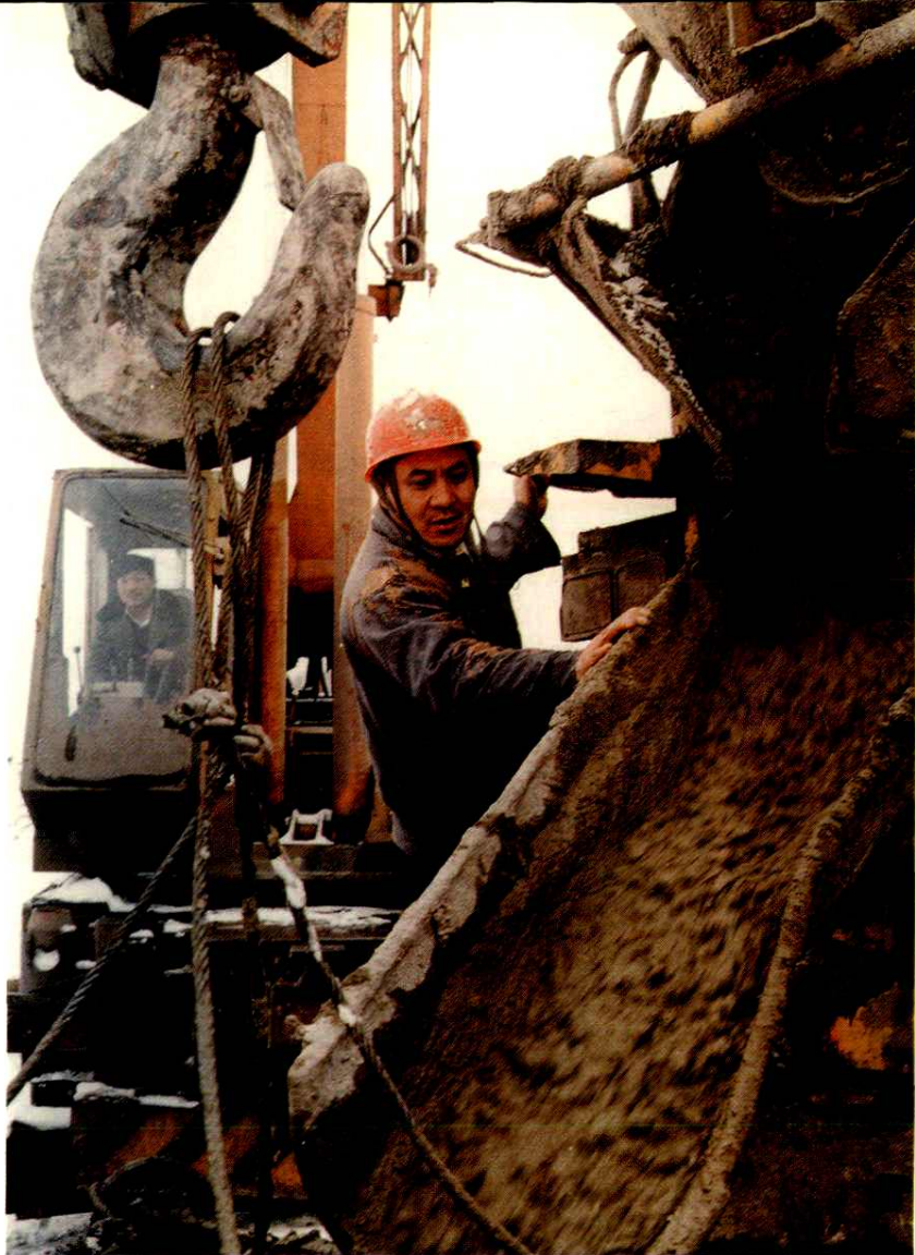
► 副省长兼省交通厅厅长、太旧高速公路建设总指挥部总指挥杜五安在施工一线参加劳动。
