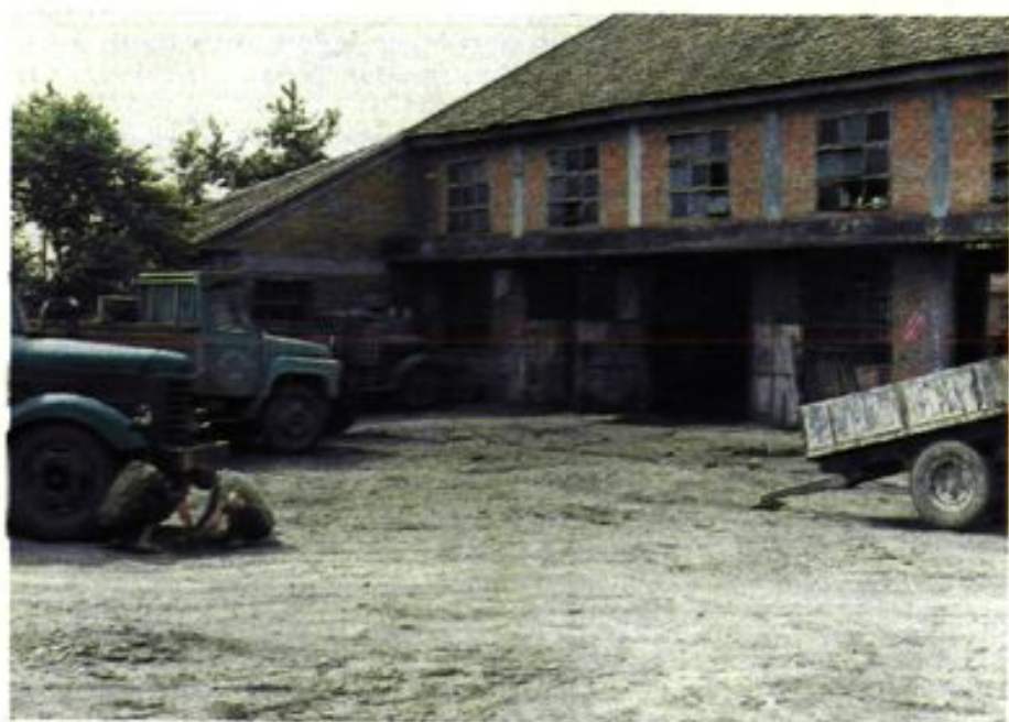
农机站修配车间
