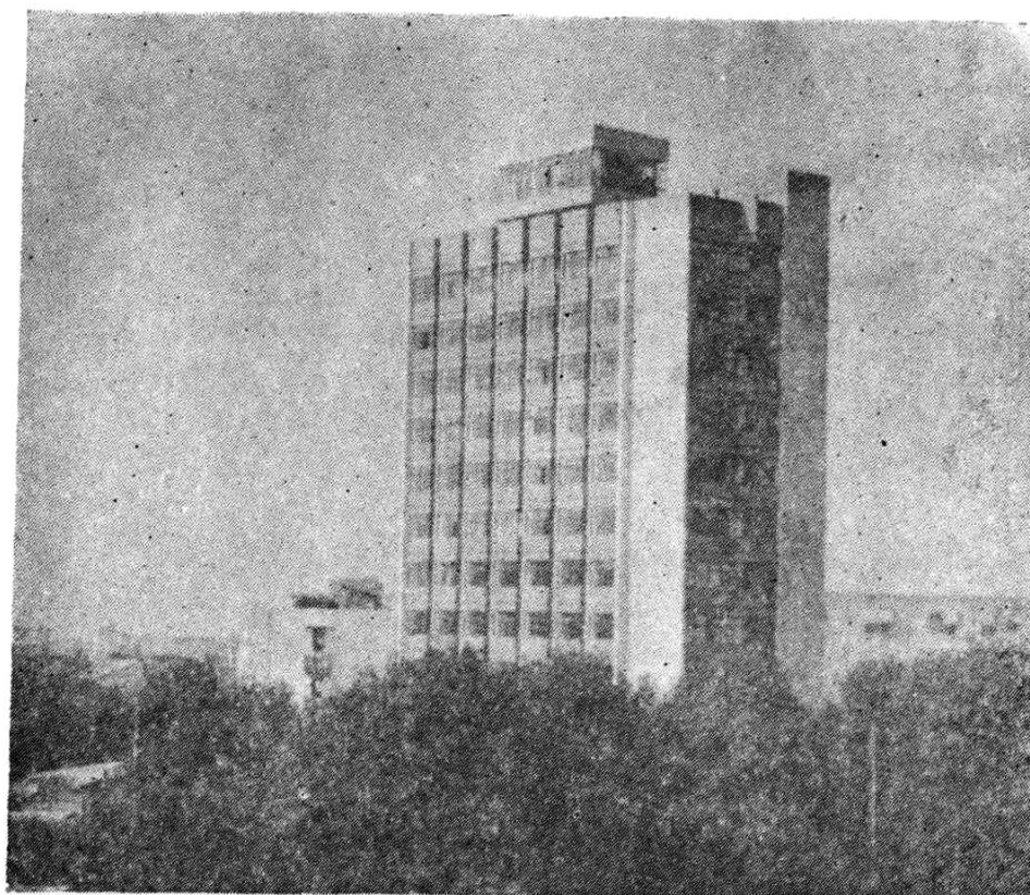
无锡市纺织工业局办公大楼
