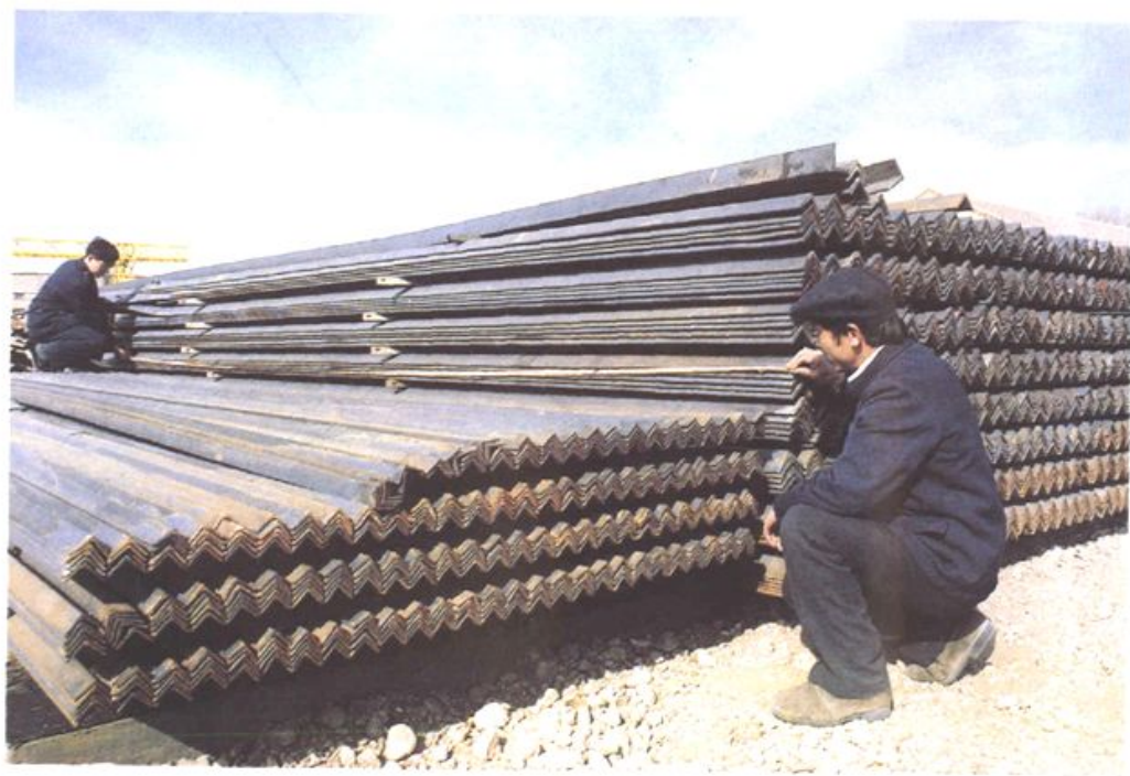
▲ 施工现场物资分类存放、堆码有序。
