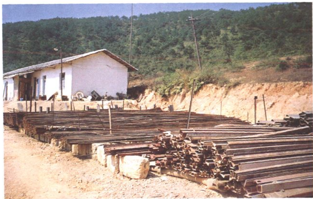
▲ 做好施工现场物资标准化管理，是局物资供应管理的重要内容。 图为京九线局信丰指挥部某工程队施工现场料场一角。(1994)
