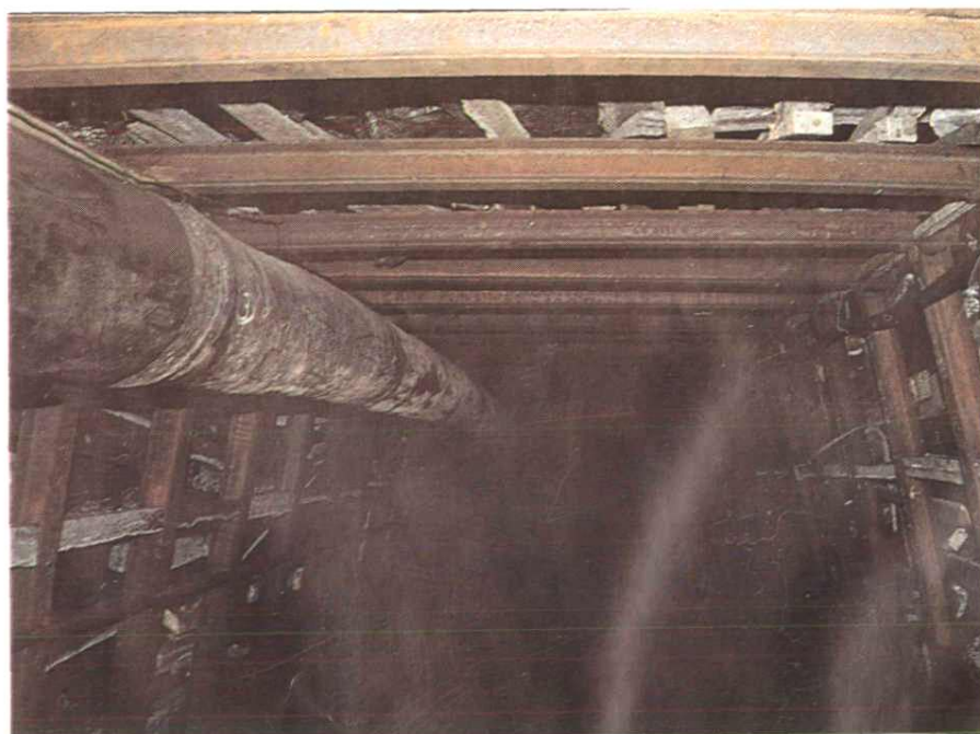
井下3804金属棚支护巷道
