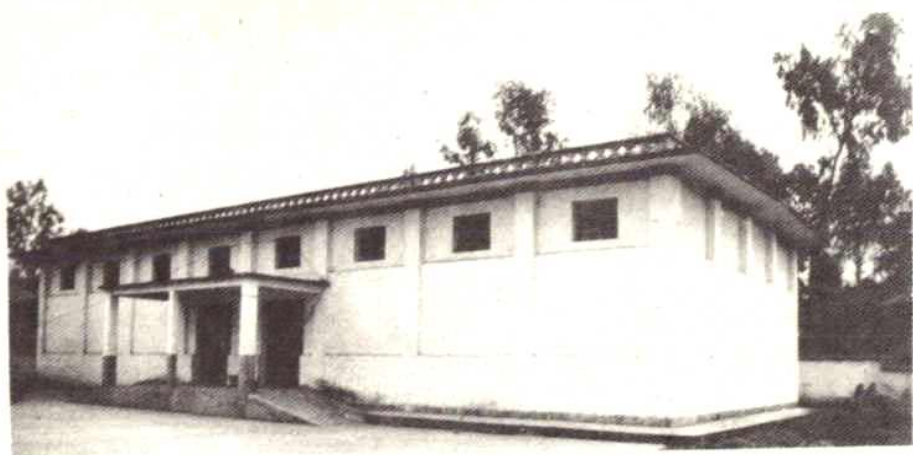
砖混水泥结构粮仓
