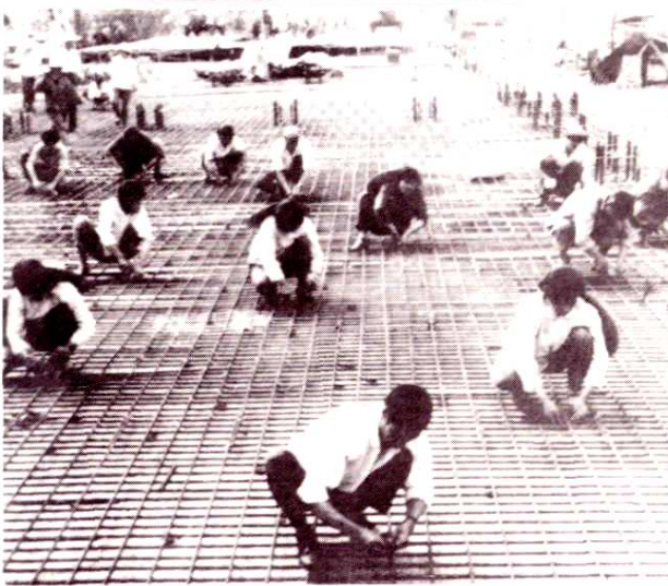
建设者们顶着烈日在编织凉水塔地基钢筋
