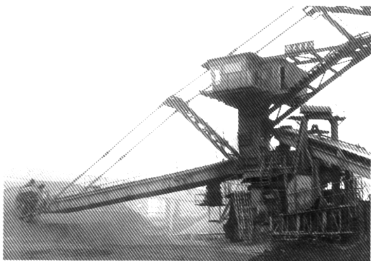
堆取料机工作现场
