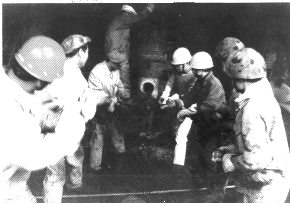
高炉车间与维修车间职工并肩作战更换高炉风渣口
