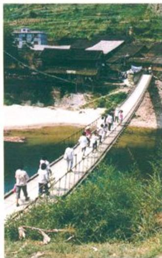
△ 两江乡明清时建有木桥,后每年架修,至二十世纪七十年代改修为八十米长,四米宽的铁索桥。
