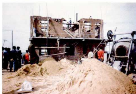
榆林市城建部门依法拆除违章建筑
