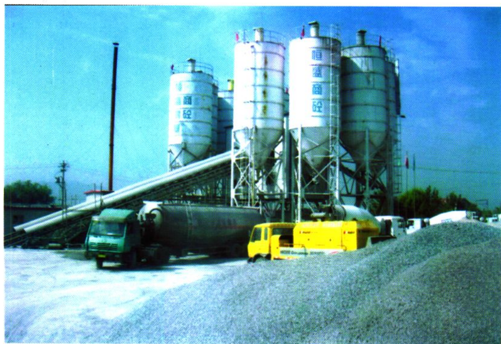
怀来恒盛水泥搅拌厂
