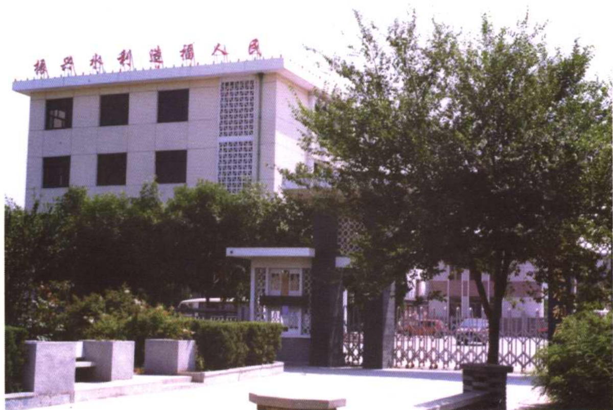
大港区水利局办公楼
