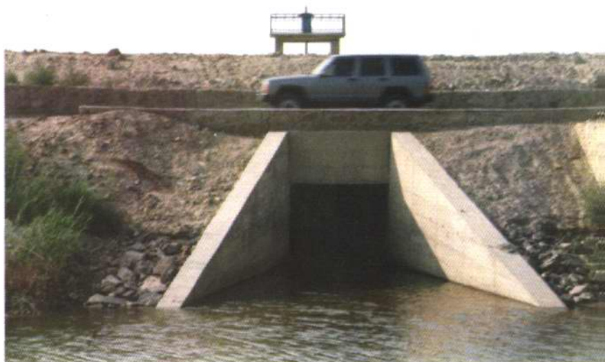
北大港水库沙井子放水闸
