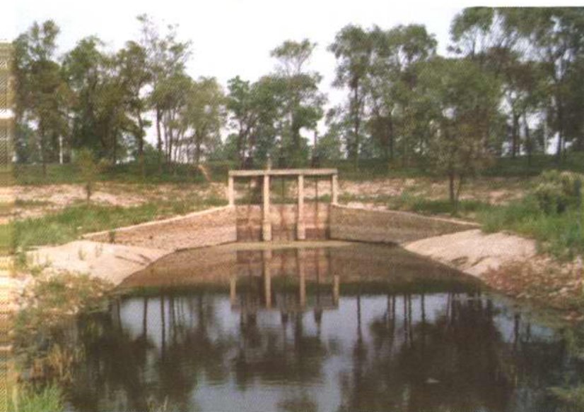
钱圈水库进水闸
