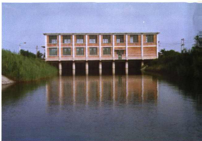
西部扬水站外景
