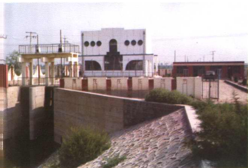
大港区中塘扬水站
