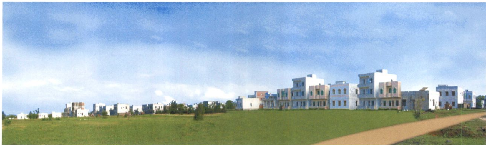
建设中的镇海新村
