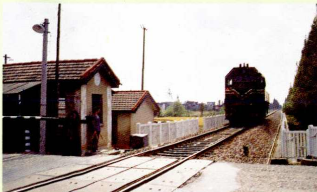
沪杭铁路金卫支线亭新乡过境路段
