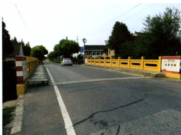
松金公路冯家楼公路桥
