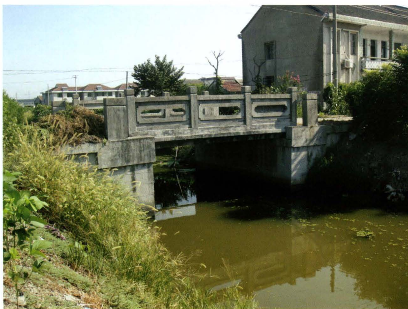
农桥 浩光村东村角中心河桥
