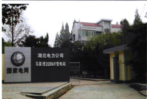
1988年2月，京山220千伏马家塆变电所建成投运
