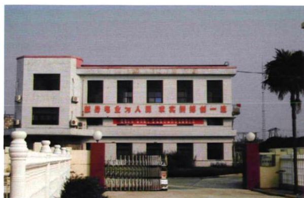
1969年1月，荆门第一座110千伏沙洋变电站建成投运
