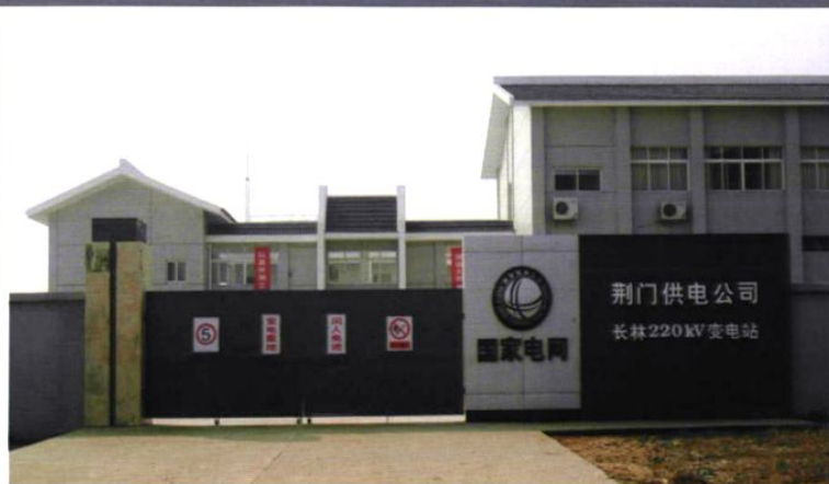
2006年11月，沙洋220千伏长林变电所建成投运
