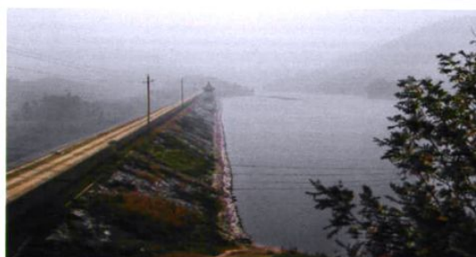
2004年8月，钟祥市在建的抽水蓄能发电站——北山抽水蓄能水电站开工建设，设计发电装机20万千瓦
