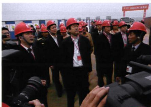
2007年11月8日，国家电网公司副总经理郑宝森（前中）视察建设中的1000千伏特高压荆门变电站
