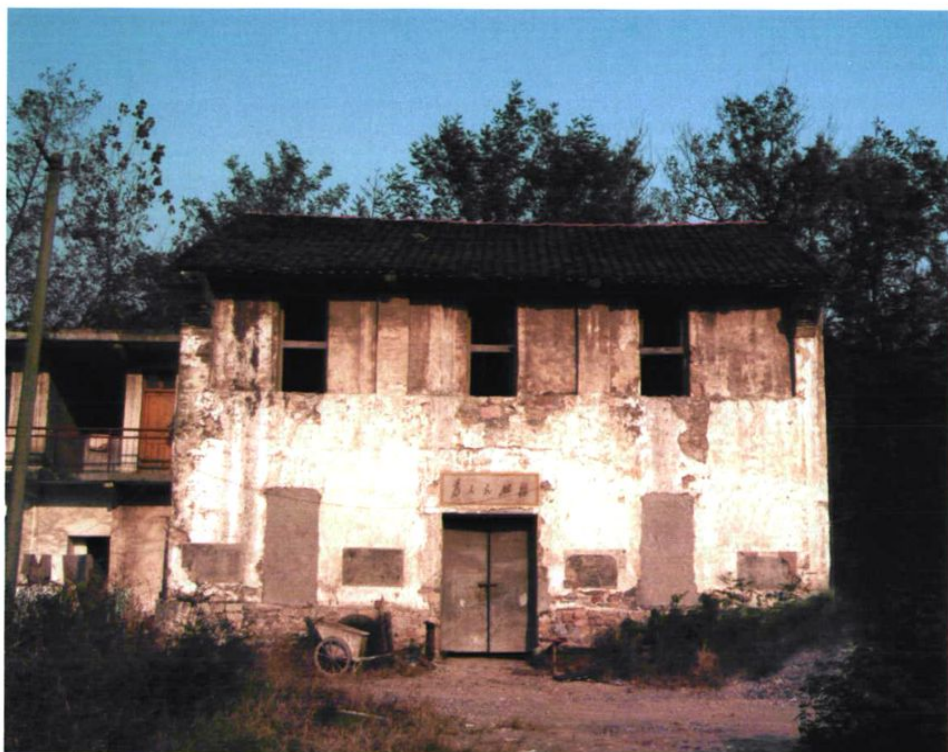
1958年7月1日，投产的七一水电站厂房旧址
