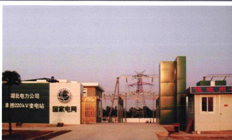
2007年12月，建设中的荆门220千伏南桥变电所
