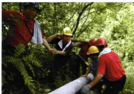
2007年9月，荆门东宝供电公司栗溪供电营业所按照荆门供电公司统一部署，实施“户户通电”工程建设
