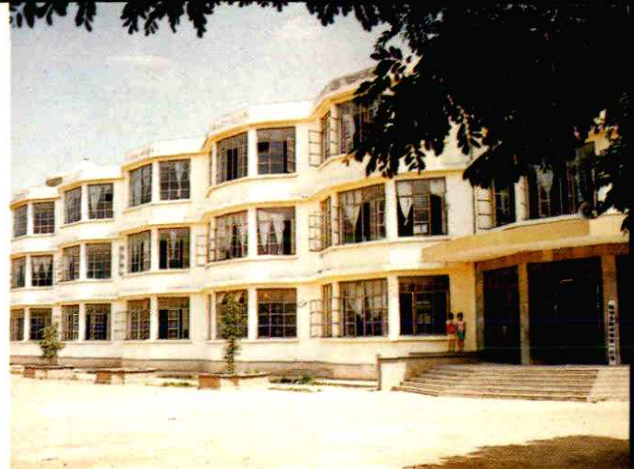
临沐镇第一小学教学楼
