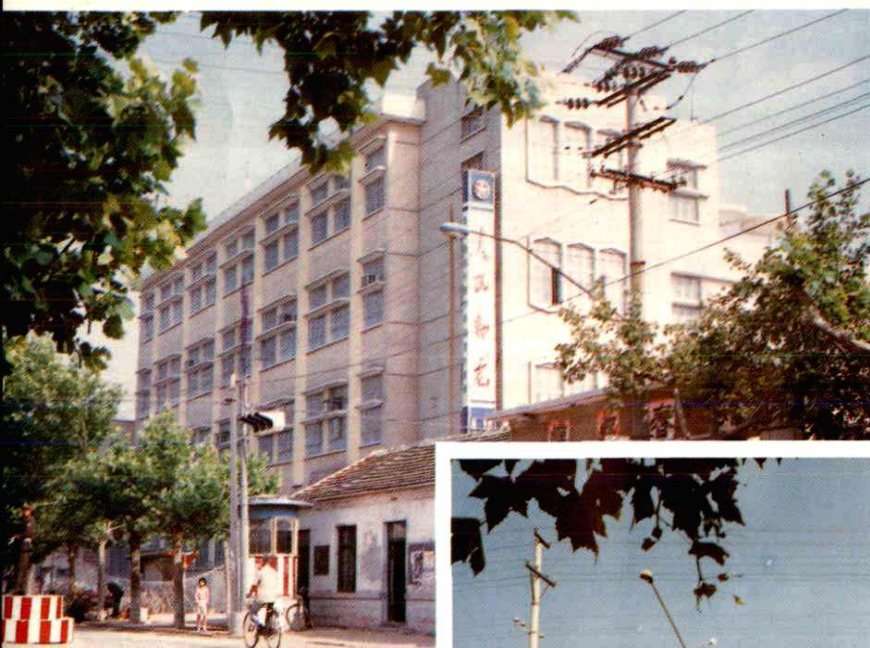
临沭电信大楼
