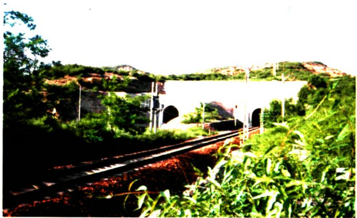
太焦铁路丹朱岭复线隧道
