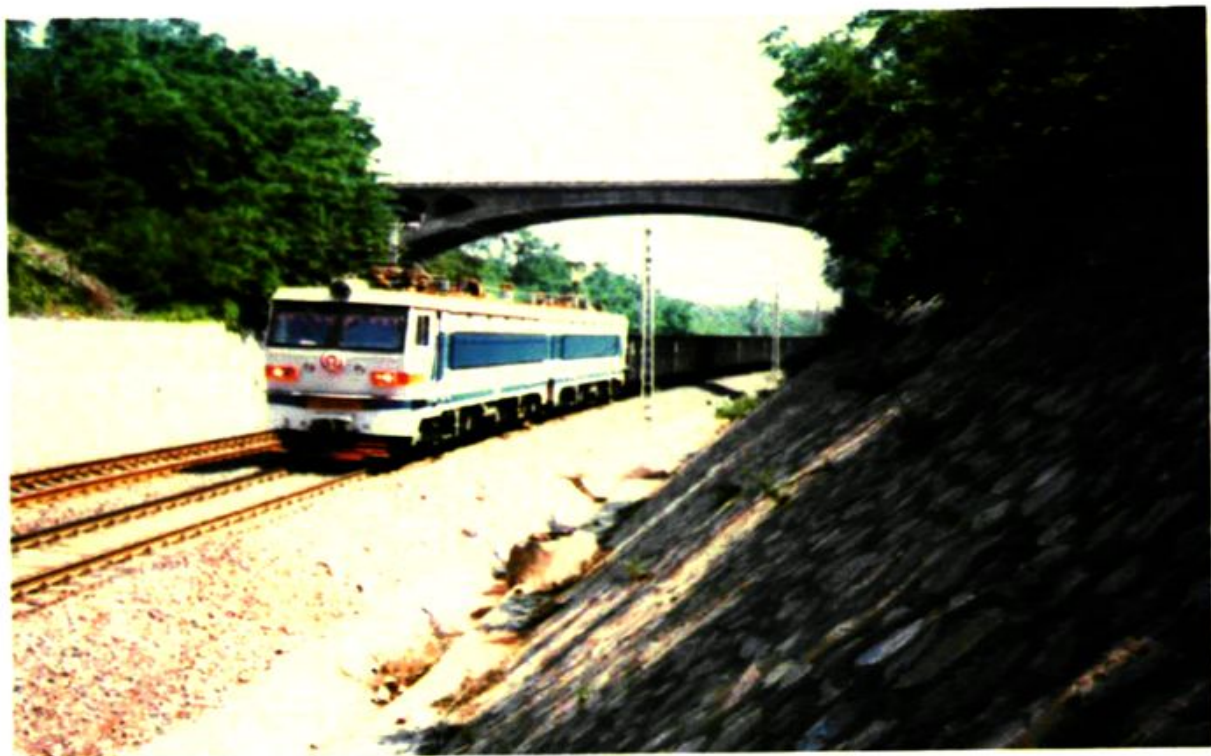
下玉井公铁路立交桥
