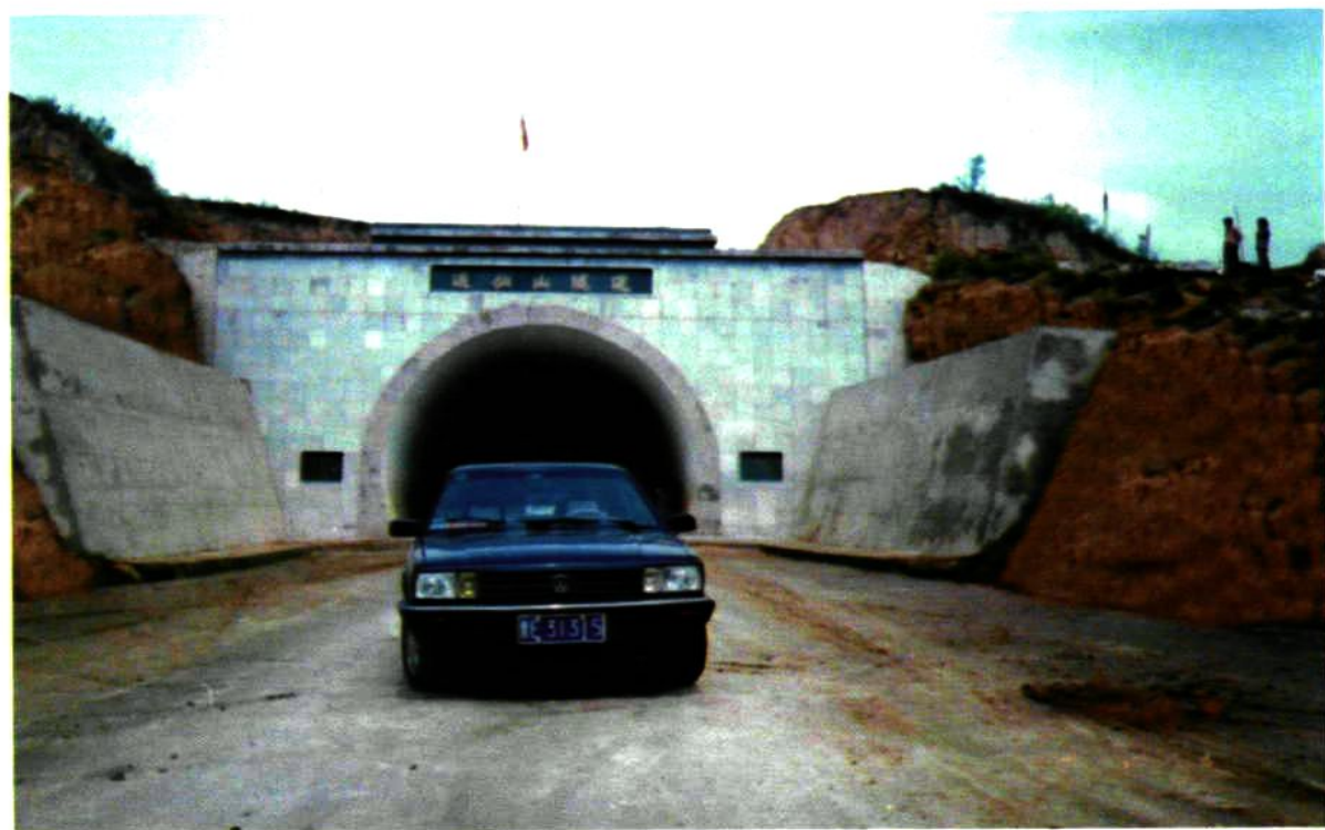
曲辉线遇仙山公路隧道
