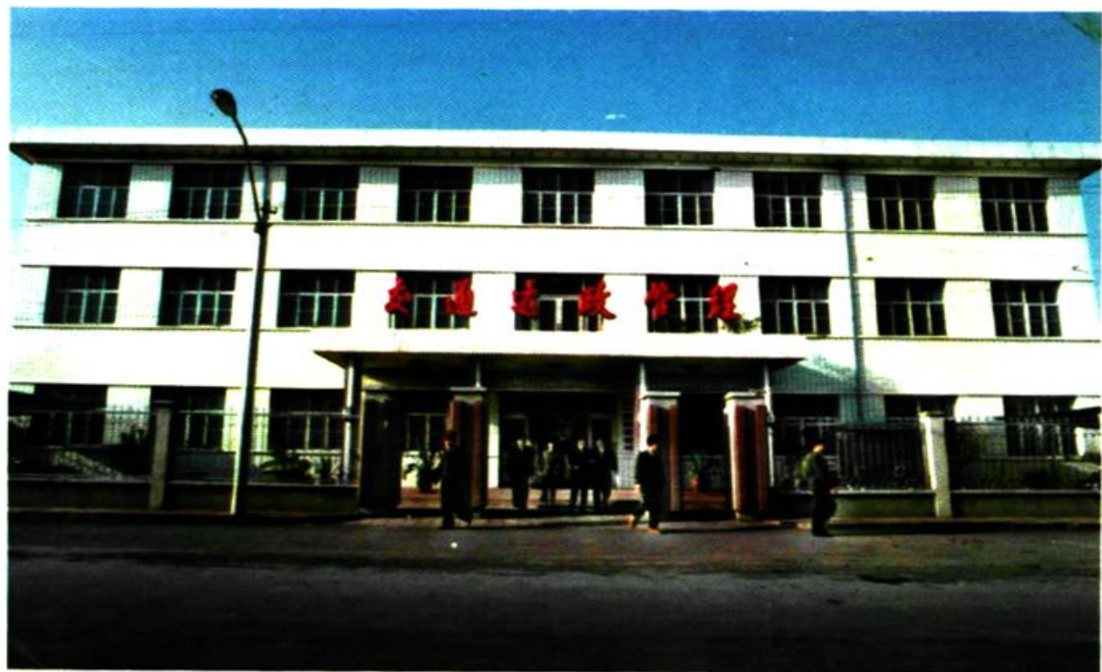
高平市交通局运管所办公楼
