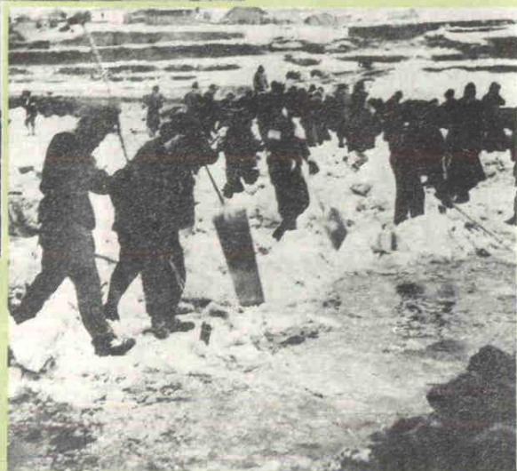
1938年修建丰满发电所劳工破冰往水下放石笼
