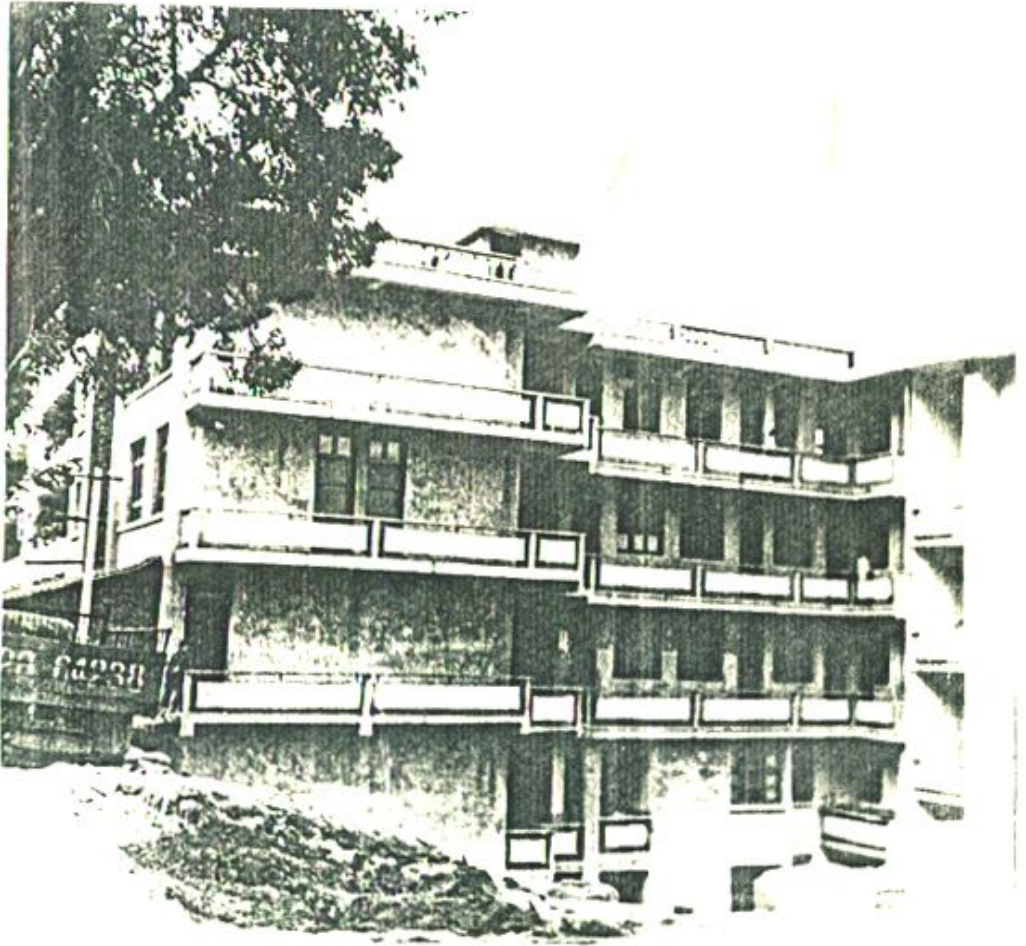
城建局办公大楼
