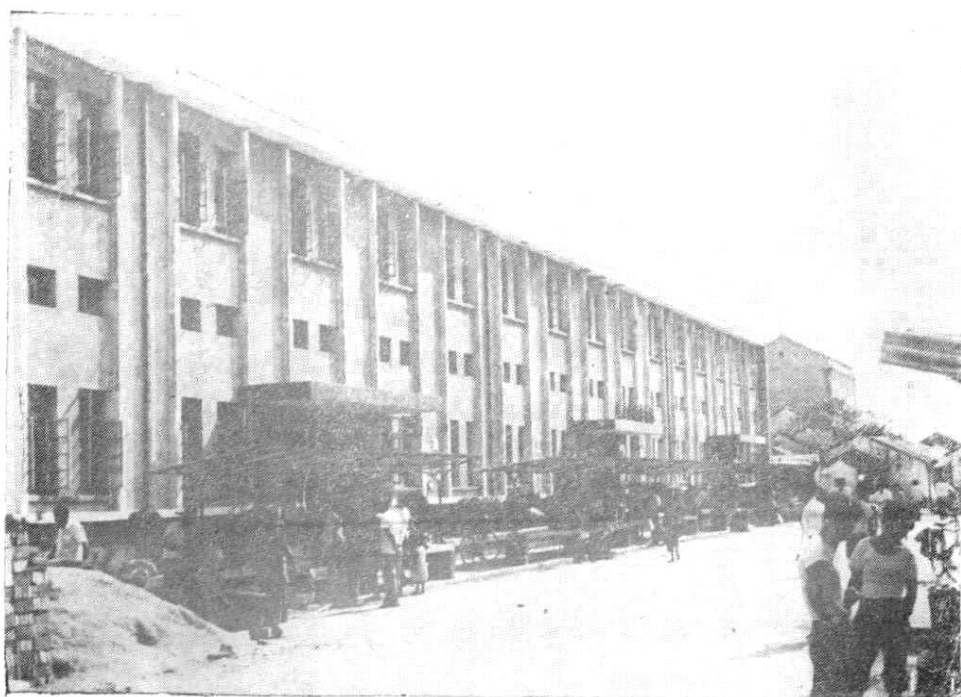
六、坂上供销社大楼
