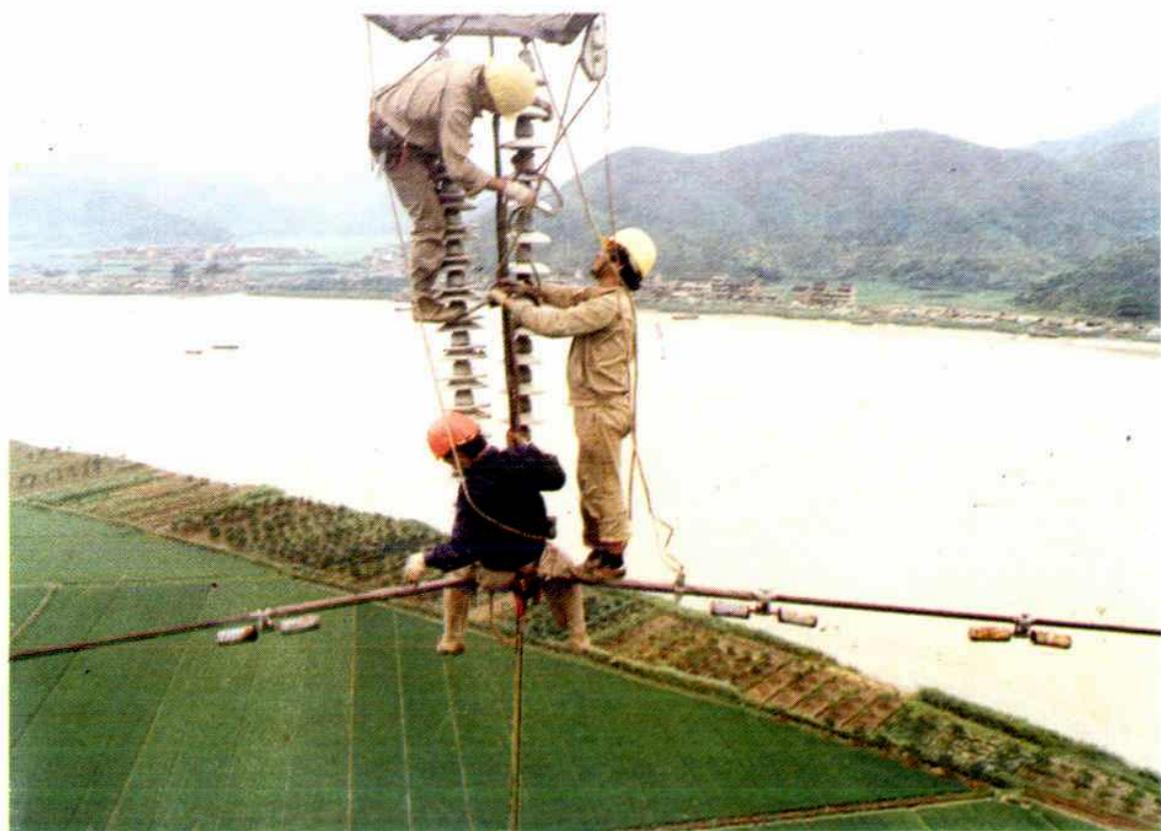
送电工正在台临 2351 线跨灵江处换装防污瓷瓶
