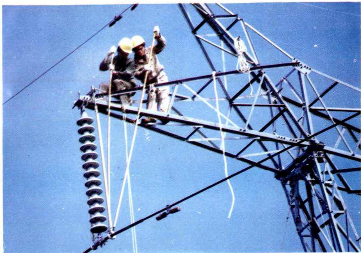
送电工在临金2357线带电换瓷瓶
