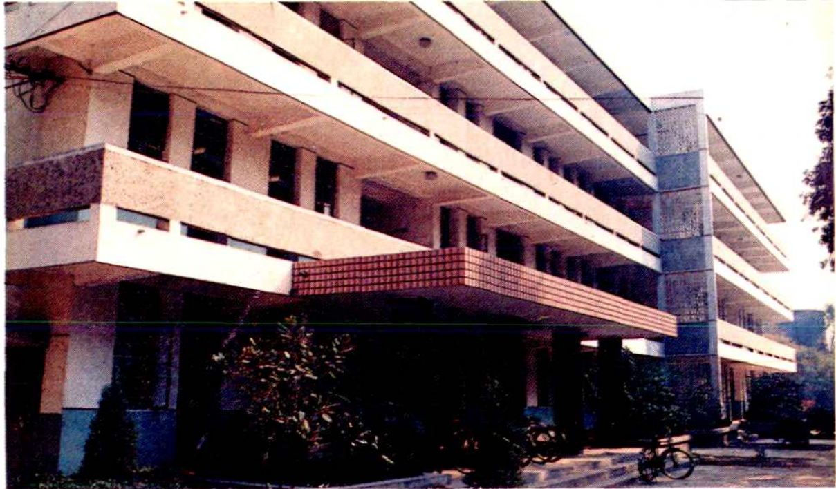
江宁县秣陵中学教学大楼
