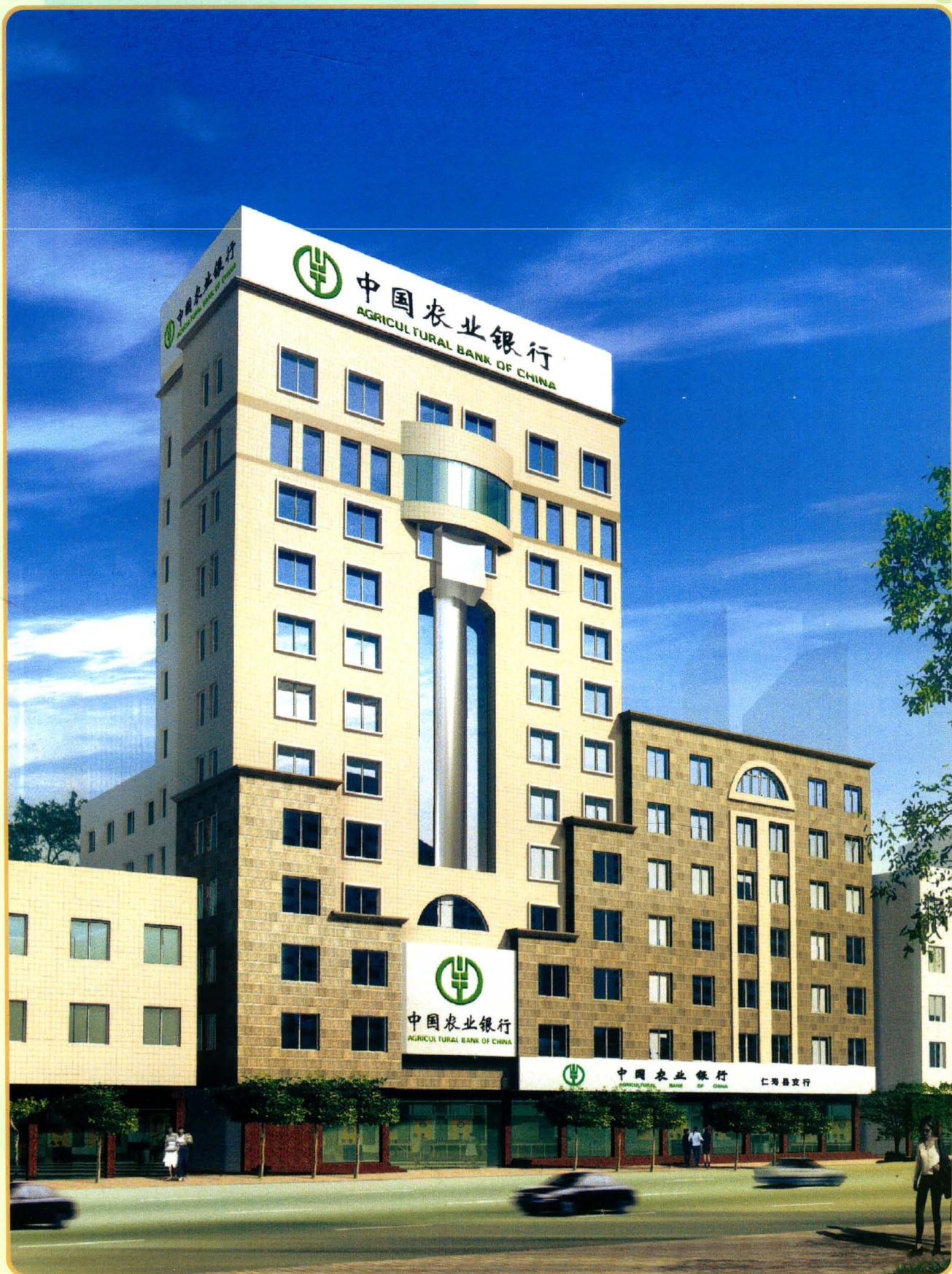
中国农业银行仁寿县支行办公大楼
