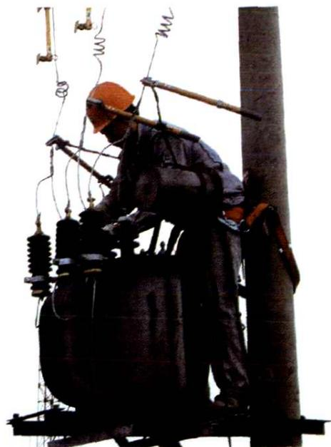
10 千伏配电变压器现场检修
