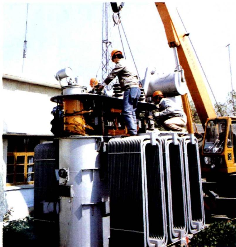
35 千伏主变压器吊芯检修
