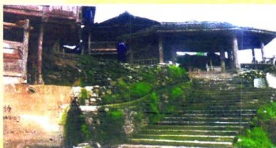
县工商联（总商会）资助忠城镇干烈村平扁村民组修建的门楼石阶。
