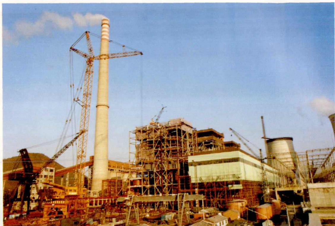
建设中的北京石景山热电厂
