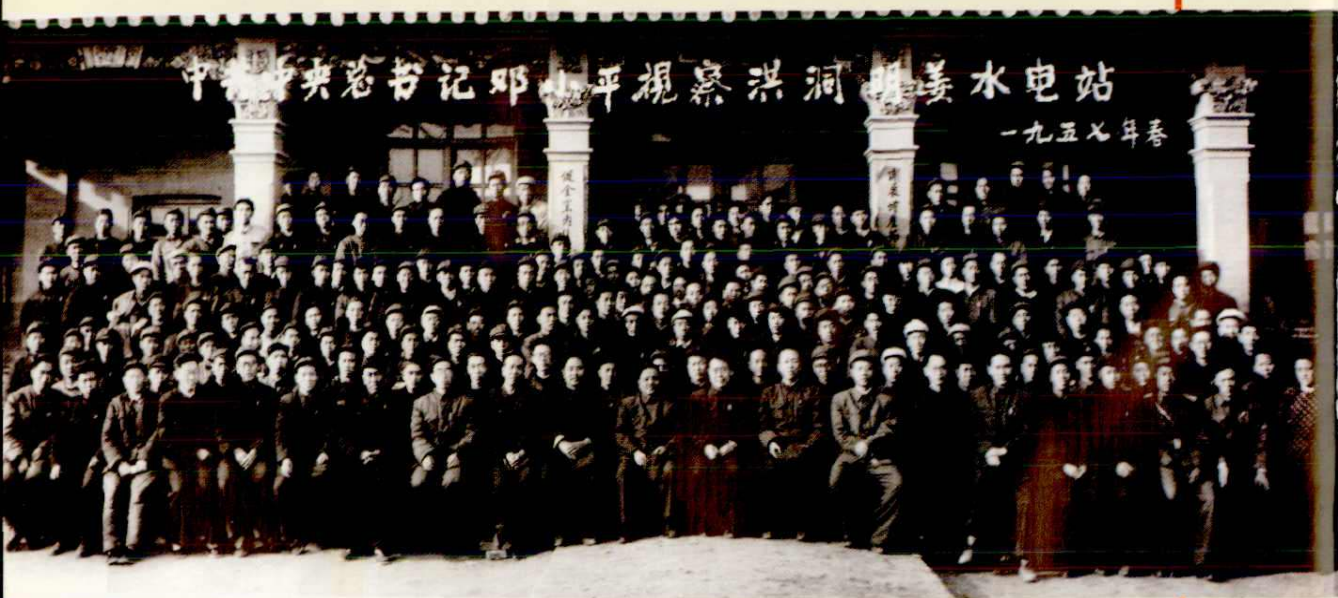
1957年春,邓小平总书记视察山西省洪洞县明姜水电站
