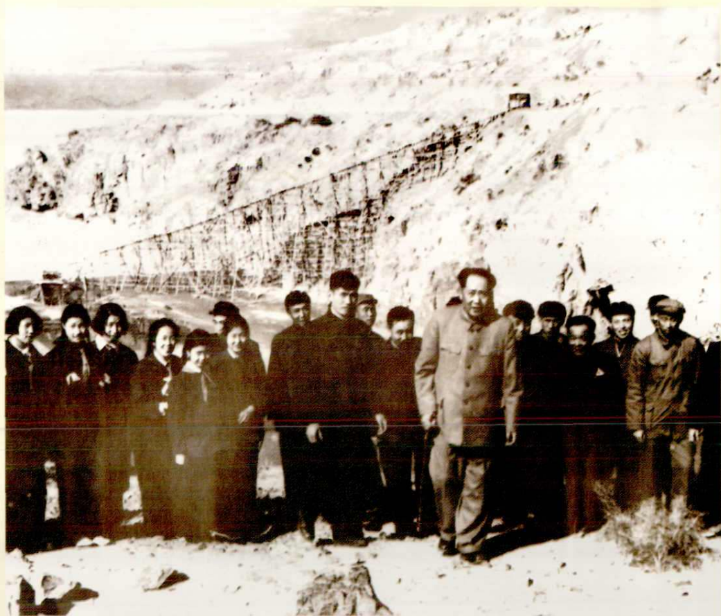
1954年4月,毛泽东主席视察官厅水库及水电站工地
