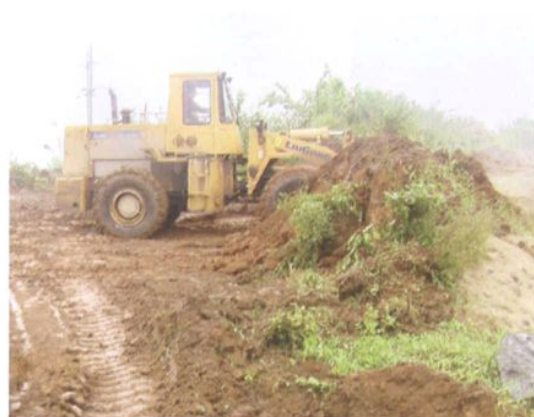
迎政乡新集镇建设工地
