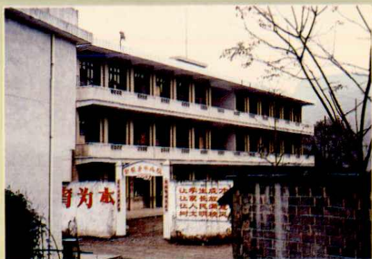
中心校教学大楼
