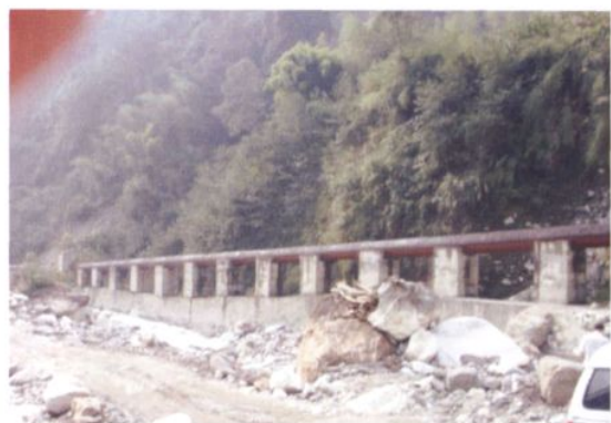
什月河二级站尾水电站
