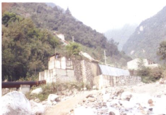
正在建设中的什月河二级站
