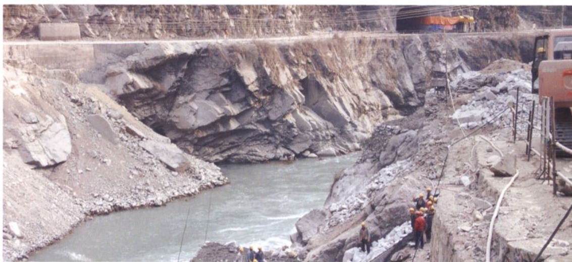
大岗山水电站田湾彝族乡境内施工现场
