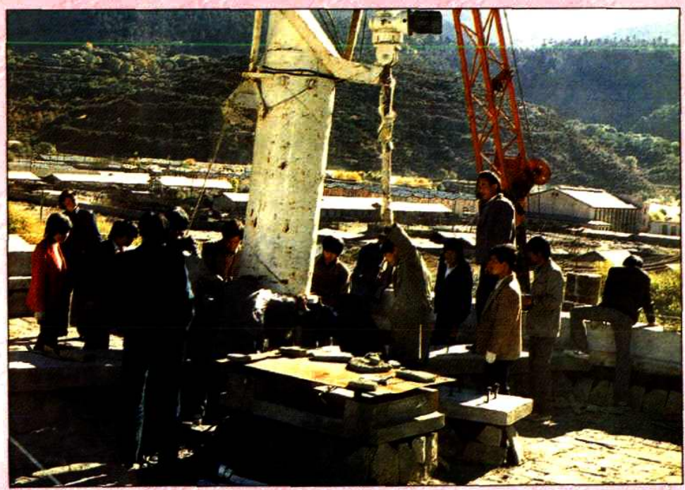
▲ 通信基础设施建设。
