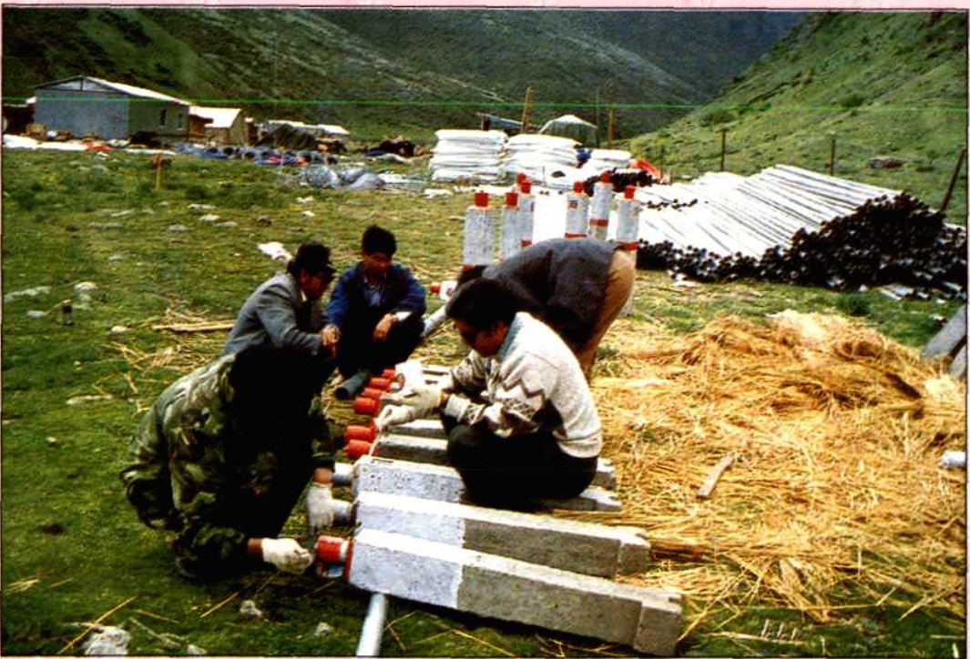
▲ 工程技术人员现场研究通信光纤工程施工方案。
