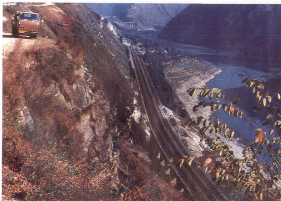
“桥上车站” 金口河火车站
