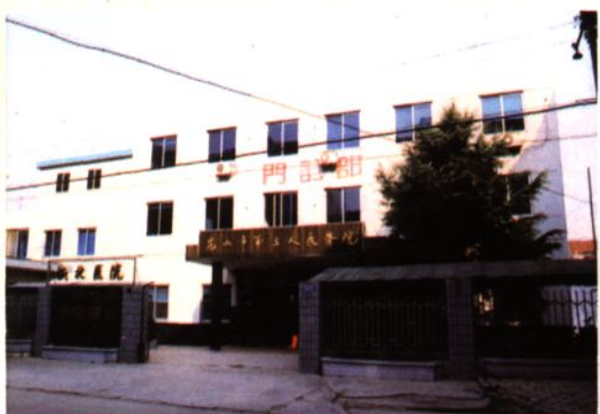
1982年7月至1999年5月昆山市第三人民医院门诊部大楼。
