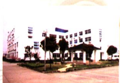
现市三院门诊部大楼背部
